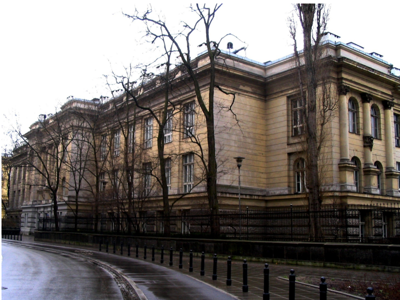
Gmach Chemii Politechniki Warszawskiej, w którym w 1900 r. została utworzona Piąta (warszawska) Izba Miar i Wag. Stan obecny
