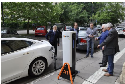
Ładowarka wraz z blokadą parkingową
