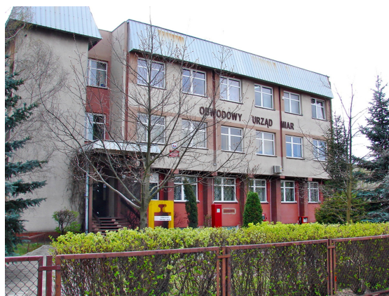
Budynek Obwodowego Urzędu Miar w Białymstoku
