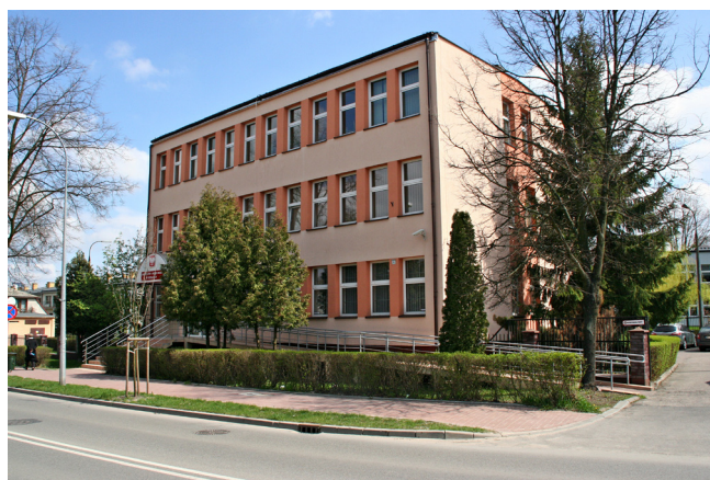
Budynek Obwodowego Urzędu Miar w Siedlcach
