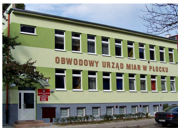
Budynek Obwodowego Urzędu Miar w Płocku
