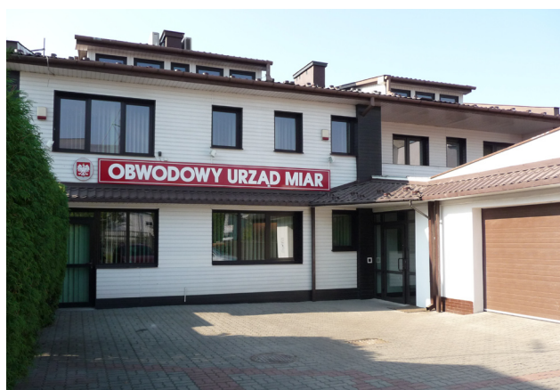
Budynek Obwodowego Urzędu Miar w Radomiu
